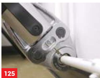
Для возможности удобного доступа монтажным инструментом к соединителям и сохранения целостности уже выполненных соединений рекомендуется соблюдать минимальные расстояния между двумя соседними соединителями, а также между осью трубы и поверхностью крепления (стена, пол, потолок). При трубах разного диаметра принимаются данные для более толстой трубы.
