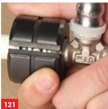
Качество опрессовки можно проверить путём прикладывания пресс-насадок на опрессованную гильзу. Зазор между концами насадок не должен превышать 2-3 мм. В противном случае следует произвести повторную опрессовку.
