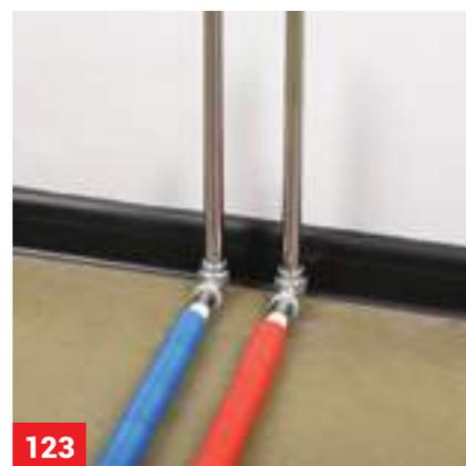
Трубопроводы систем радиаторного отопления, прокладываемые в полах, рекомендуется монтировать в защитном гофрированном пластиковом кожухе или в тепловой изоляции.
