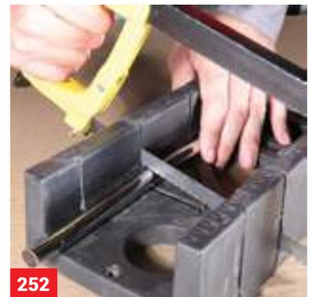
Допускается разрезать нержавеющие трубы ножовкой по металлу с обязательным применением стусла.
